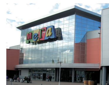
Торговый центр «Мега», г. Санкт-Петербург
