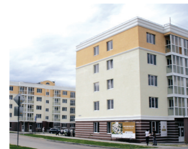
Жилой комплекс «Новый свет», г. Волгоград
