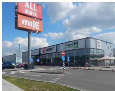
Строительный гипермаркет Mile, г. Минск
