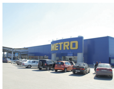
Торговый центр Metro, г. Пермь
